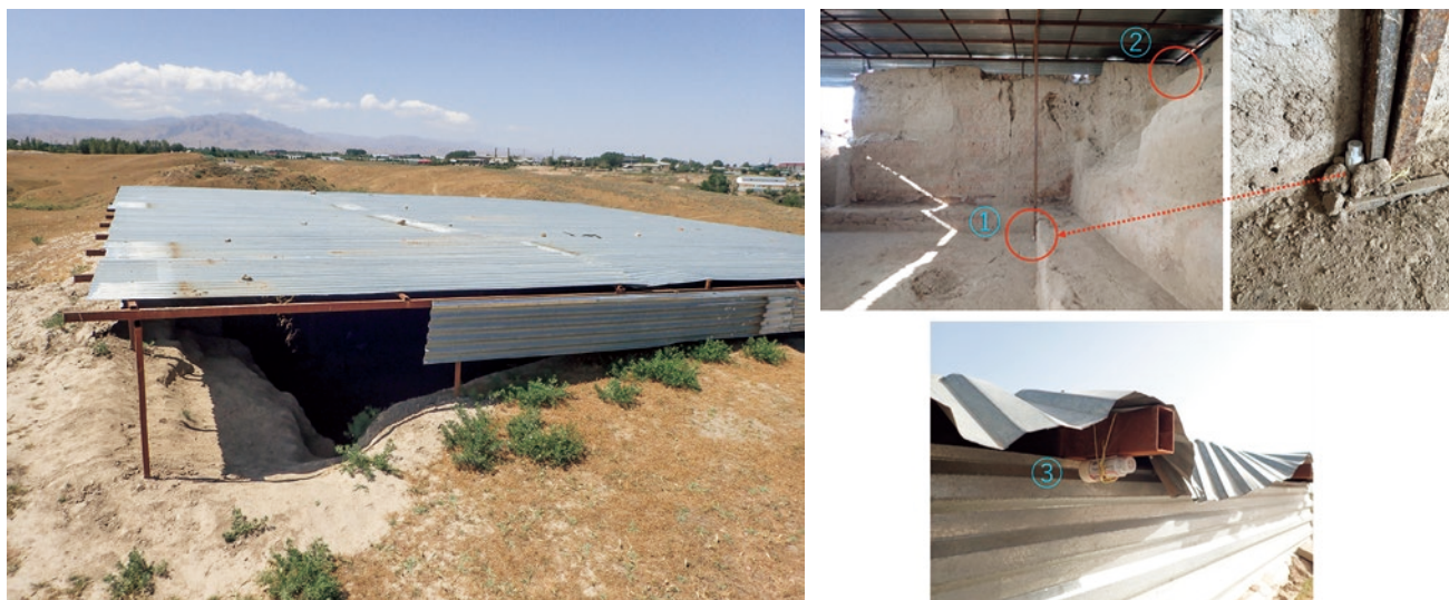
図7 Room 1〔大ホール〕の上部に設けた覆い屋根(左)と計測機の設置場所(右) 内側：床面【①】と天井付近【②】、外側：直射日光の当たらない屋根の陰【③】に設置
