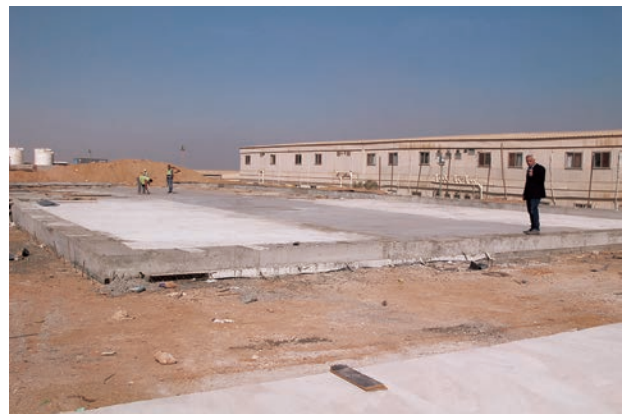
図8 大エジプト博物館の敷地内に設けた新たな作業場の基礎ここにギザ遺跡の施設を移築して組み立て復原、展示に向けた作業を始める
