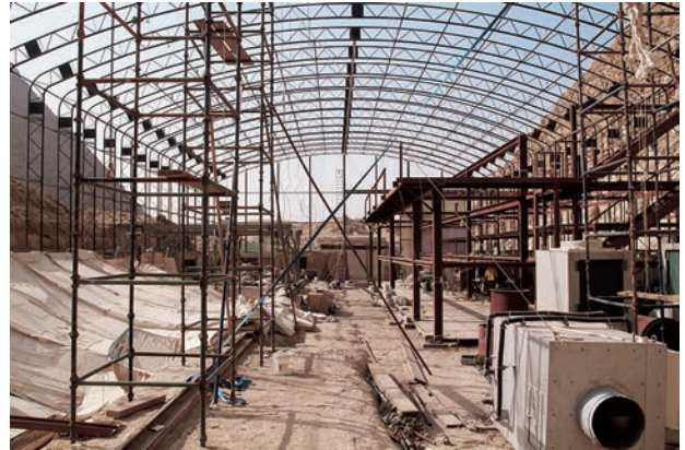
図7 解体中のギザ遺跡の発掘・保存修復施設
