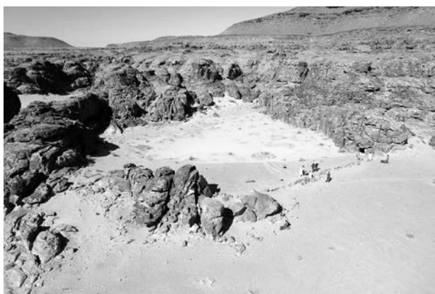
図4 ワディ・グバイ 10 号遺跡：1039 号ダム全景(南東から)
