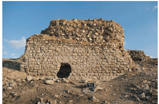
図6 アクロポリスの「北西門」正面部分。モルタルを使用した石組みで建造。
