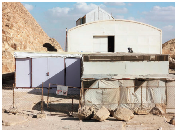
図2 第2の船プロジェクトの現場
