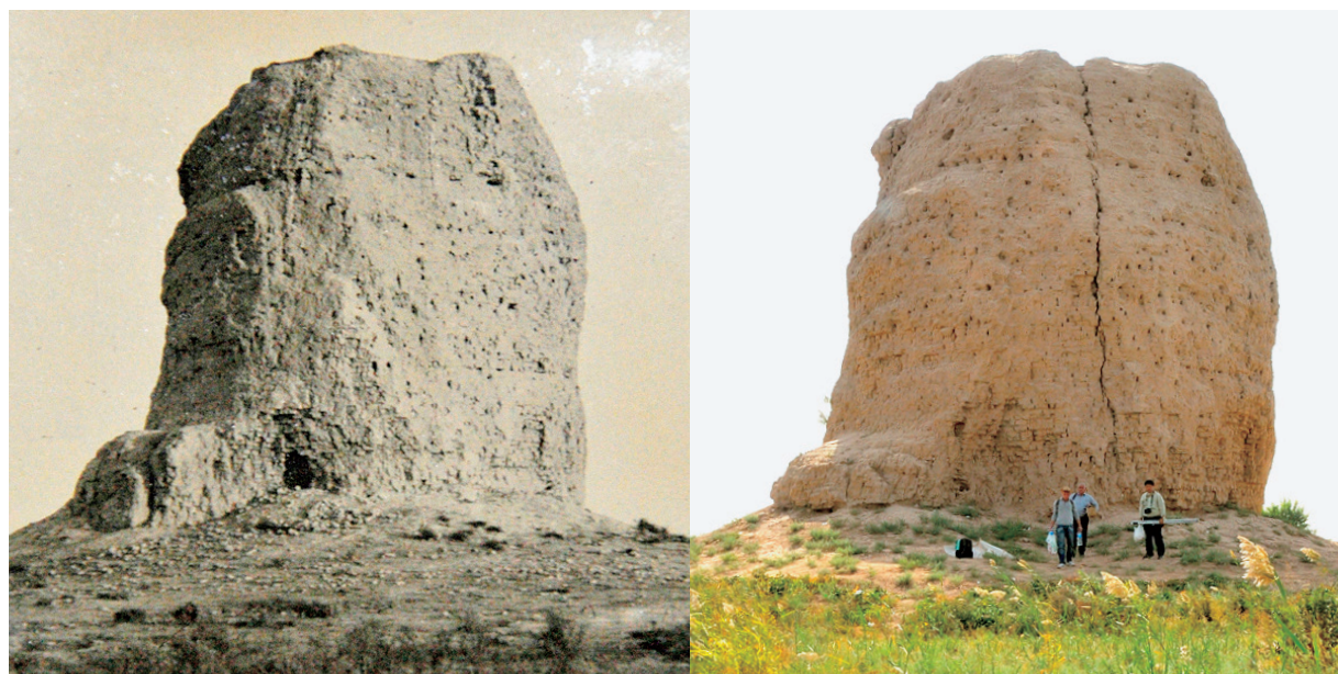
図2 写真の対比からみた亀裂の進行
