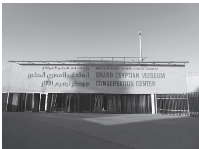
図6 大エジプト博物館保存修復センター外観 (2016年12月撮影)
