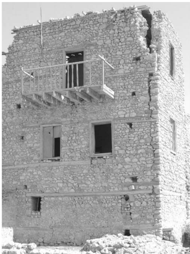
図1 キーラーニーの珊瑚造建築、その1
