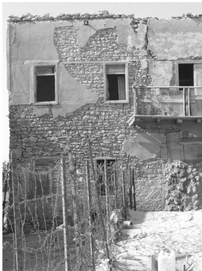
図2 キーラーニーの珊瑚造建築、その2
