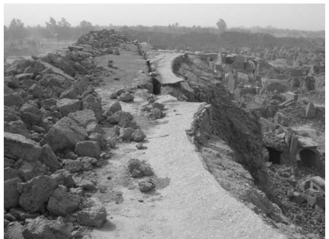
図12 南面外城壁の亀裂
